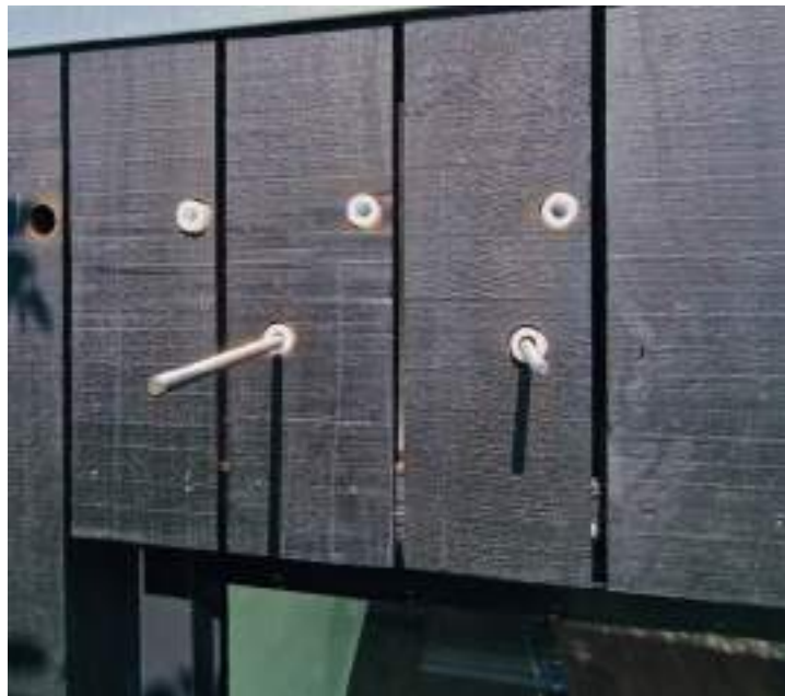
Chemische montage in binnenmuur of betonvloer met opvulkokers voor gevels en uitbouwen met houten afwerkingen.
