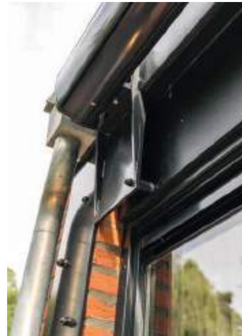
Maatwerk stalen beugels voor speciale montage voor overstek of langs regenpijpen.
