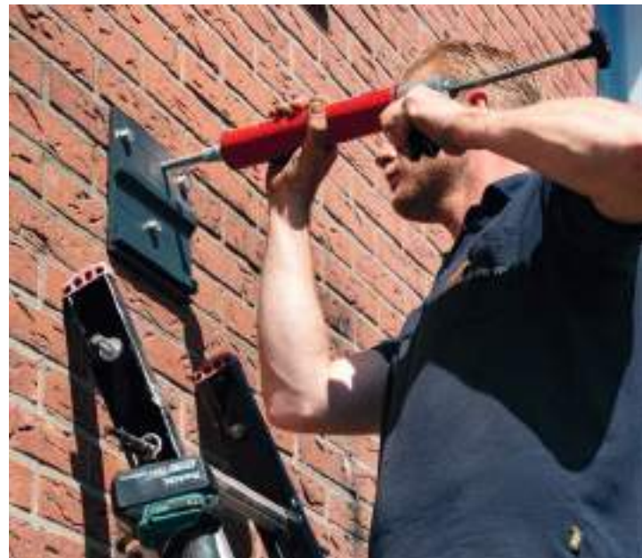
Chemische verankering in stenen muur voor montage op muren met poreuze stenen of voegen en voor montage voor schermen met een uitval van 350 of 400 cm.
